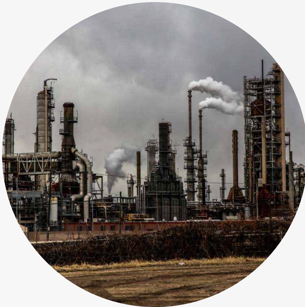
Generación de energía
